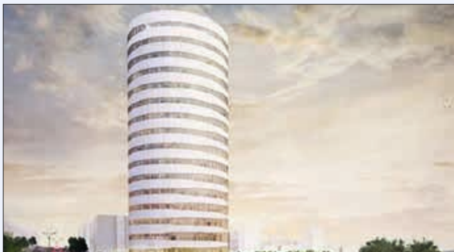
Før sommeren har Lindab oppstart på leveranse av sin nye kjølebaffel, Solus. Leveransen er knyttet til prosjektet «Runda Huset» i Munksjöstaden i Jönköping som er den første virkelige store leveransen av Lindabs nyutviklede inneklimaløsning.
