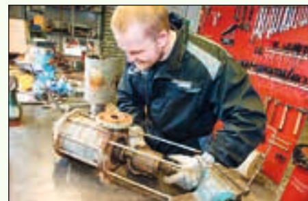
Servicetekniker Magnus Eriksen sørger for service på en kuldemediepumpe.
